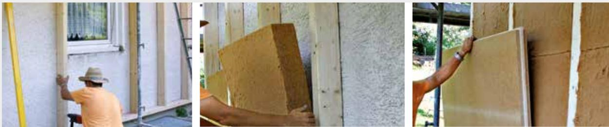
Wandsanierungsmöglichkeit von außen: PAVAFLEX zwischen Holzständer und vollflächiger Holzfaserdämmung ISOLAIR für WDVS oder Holzschalung.
